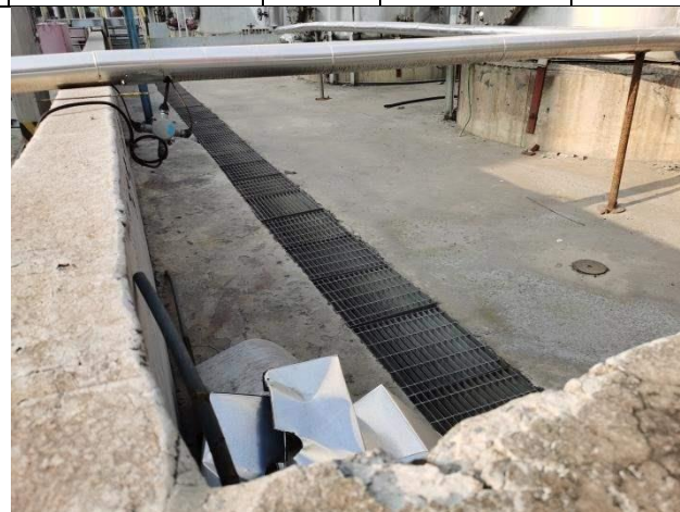
乙二醇成品副产品罐区围堰
